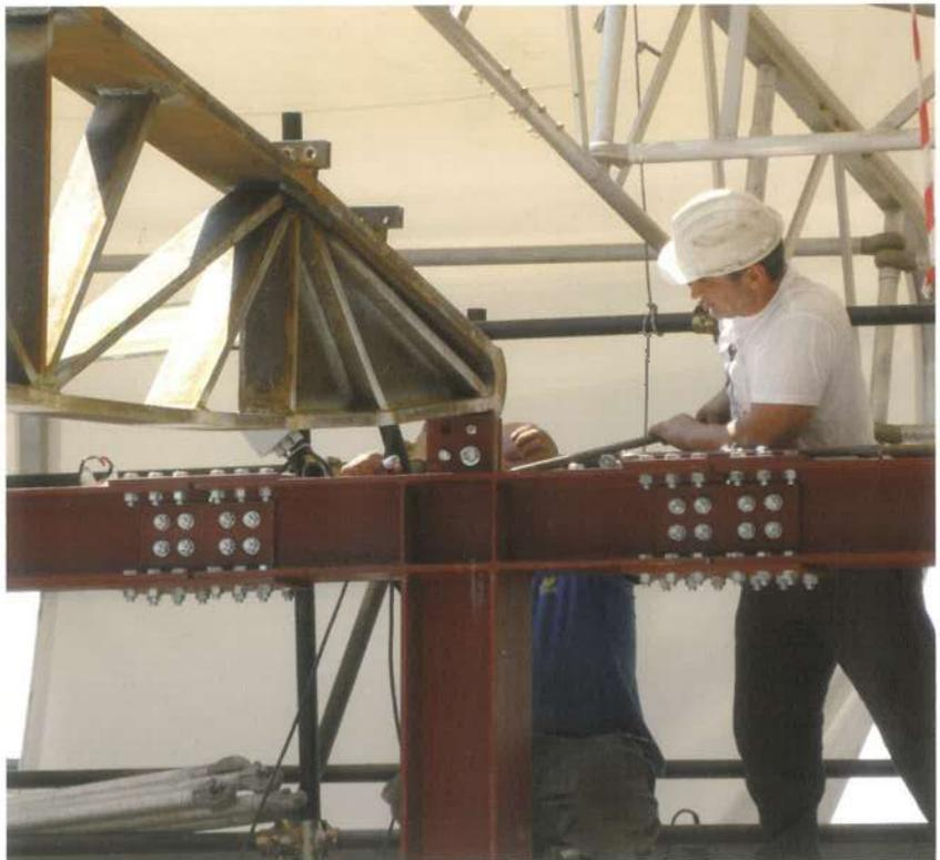
Fasi di calettamento della piastra verticale di ancoraggio della trave nell'elemento di ricevimento ad U in corrispondenza dei pilastri della struttura perimetrale e successivo fissaggio mediante bullonatura.
